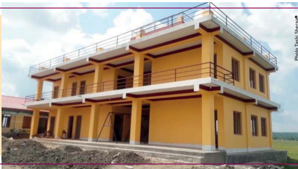
Le bâtiment final.
