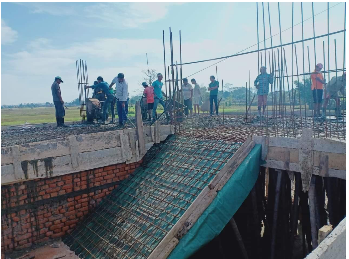
Coulage de la dalle du 1 er étage. Photo Phuri Sherpa©
